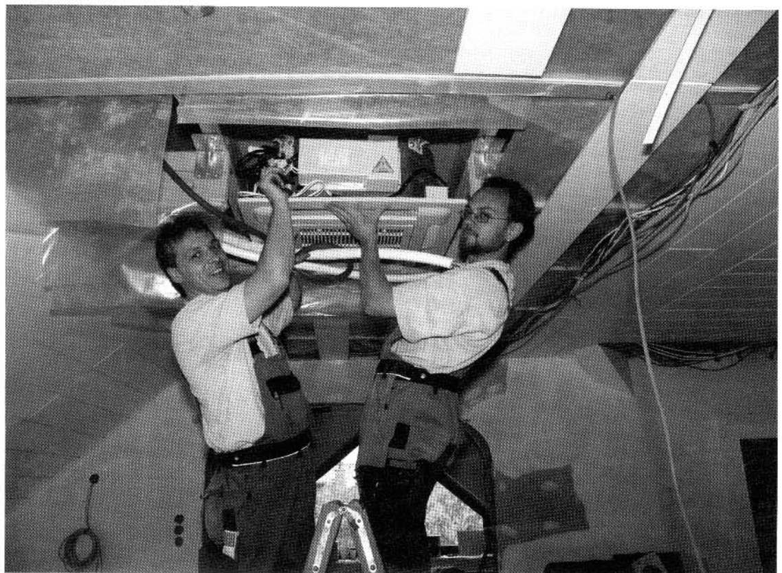
Der terminlich starke Druck bei diesem Objekt konnte den Spass der beiden Monteure Harald Effert und Thomas Schöpf bei der Montage des Vaillant Klima-Kassettengeräts VAHE OSOK nicht verderben.
