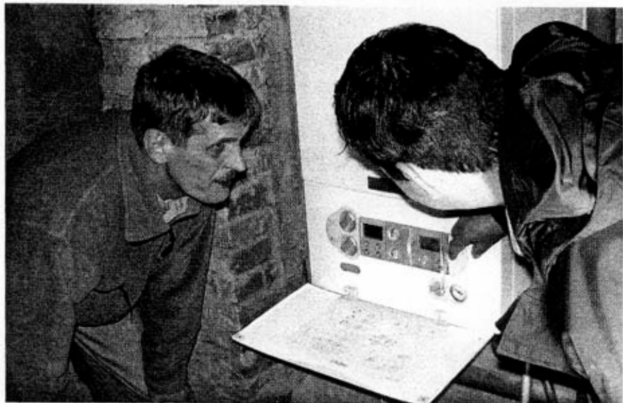
Nach der Heizungssanierung sind die Mieter des Objektes in Köln-Dellbrück von dem Leistungsprofil des ecoTEC exclusiv begeistert: „Nach den vergleichsweise einfachen Etagenheizungen bisher haben wir jetzt ein mehr als zeitgemäßes Komfortniveau bei der Wärme- und Warmwasserversorgung bekommen.“
